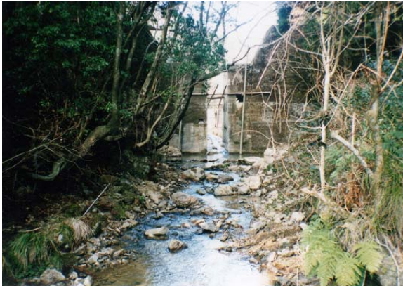
写真7 スリットを付けた砂防ダム
