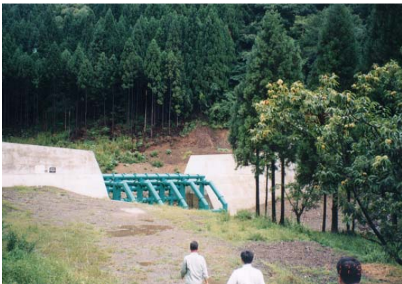
写真8 鋼管製の砂防ダム(建屋川水系)
