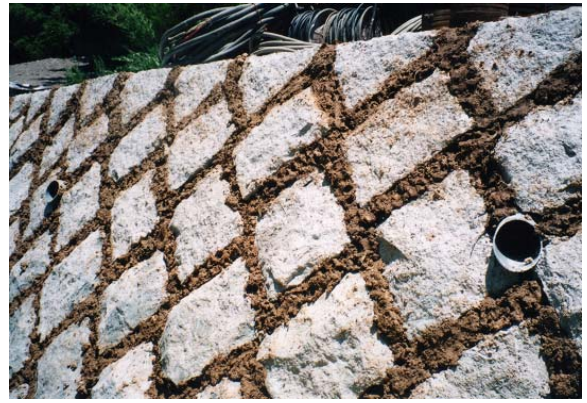
写真10 深い目地に詰めた土
