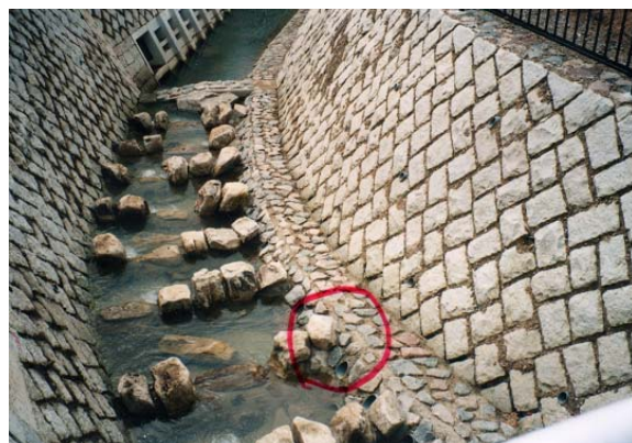
写真4 全面多段式魚道とエンビ管(円内)
