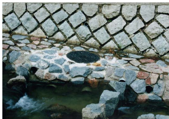
写真5 マンホールの巢穴
