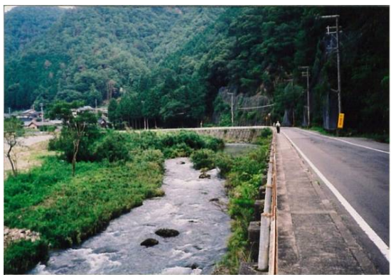
写真 1 工事前 (2006.8 道路が狭く、除雪車が通ると歩道が埋まってしまう)
