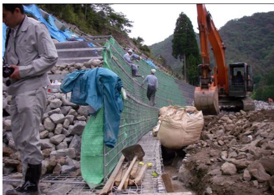
写真 9 石の隙間から土砂が抜けないように緑のシートを (2008. 6)
