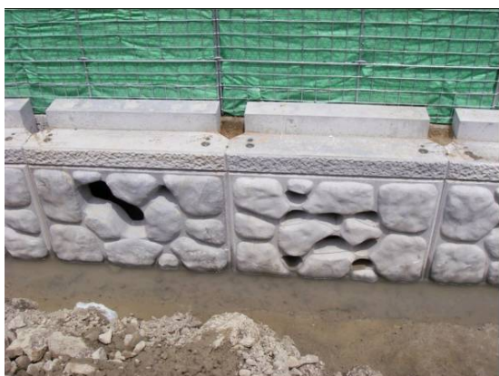
写真 11 石の入った籠の下は“はんざきブロック”
