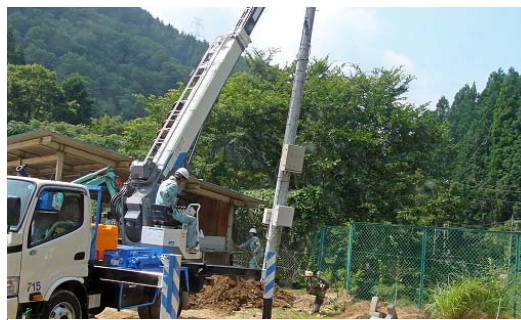
猛暑の中、アンテナ柱を移設(アンテナ柱の南西には葉が茂っている)
