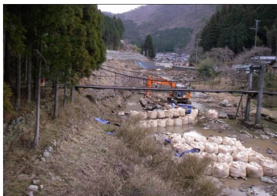
写真 6 工事開始 (2008.3 木工沈床部の水抜き)
