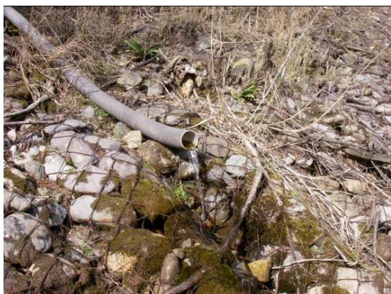
写真 3 山の中に3本の井戸が掘っており、水を 抜いている
