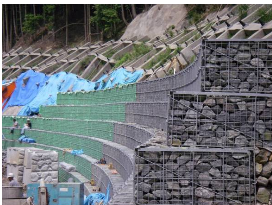
写真 10 手前の籠は昔の工事
