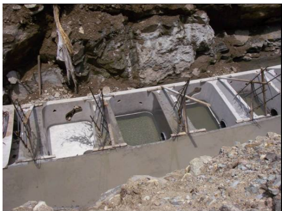
写真 17 左岸側の工事は大型はんざきブロック (2010. 7)
