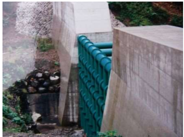
写真 12. ジャングルジム型砂防ダム （養父市建屋川支流）
