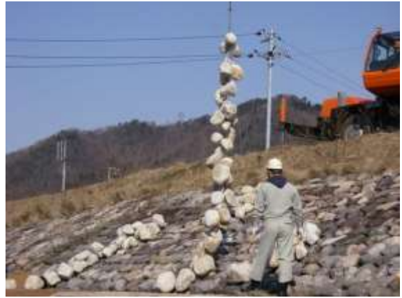
写真 19. すずかけ（工事中、出石川）
