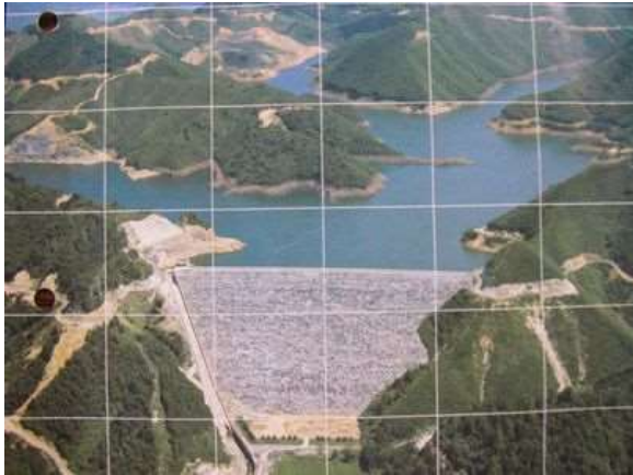
写真3. 黒川ダム（ロックフィル・ダム）とダム湖
