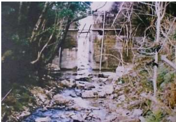
写真 17. 切り取ってスリット型砂防ダムに （兵庫県篠山市西山川）
