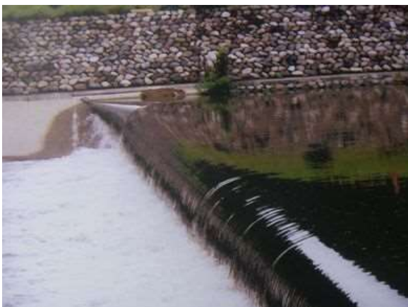
写真 18. ゴム堰（ファブリダム）（出石川）
