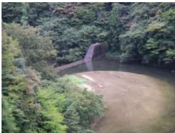
写真5. 宇佐川大堰堤の上流の堆砂状況
