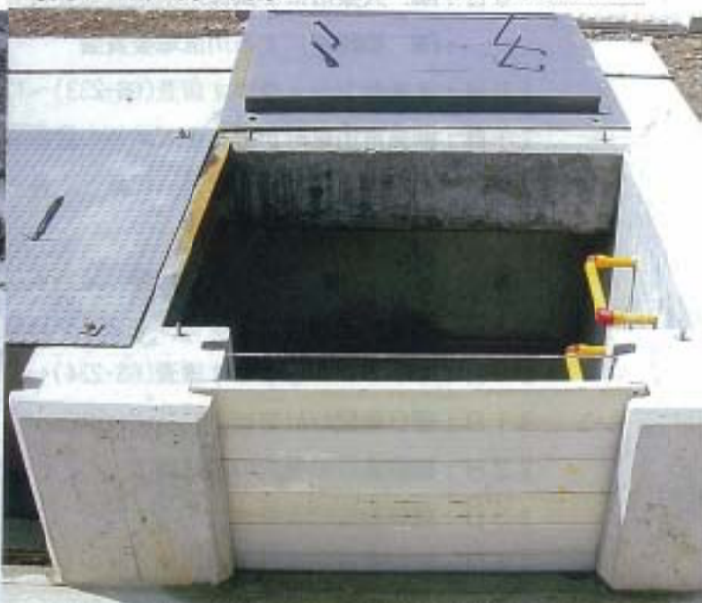
写真4 観察施設のガラス窓と雨戸
