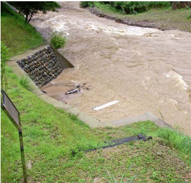
写真3 河川ステーションも水没
