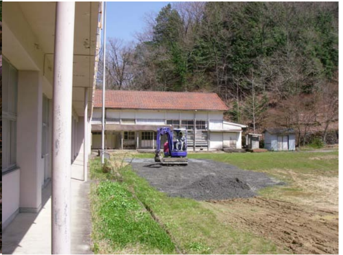
写真1 駐車場の整備
