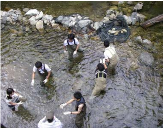
写真9 大阪府立大生の若い力で水制が完成
