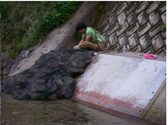
写真10 ポンプピットへの砂泥流入防止を
