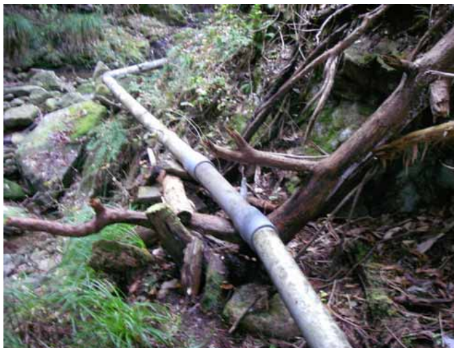
写真 1 猪の子谷の集水配管の修理完了
