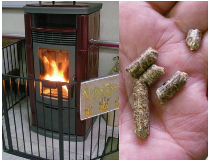
写真10 ペレット・ストーブ (豊岡市役所)
