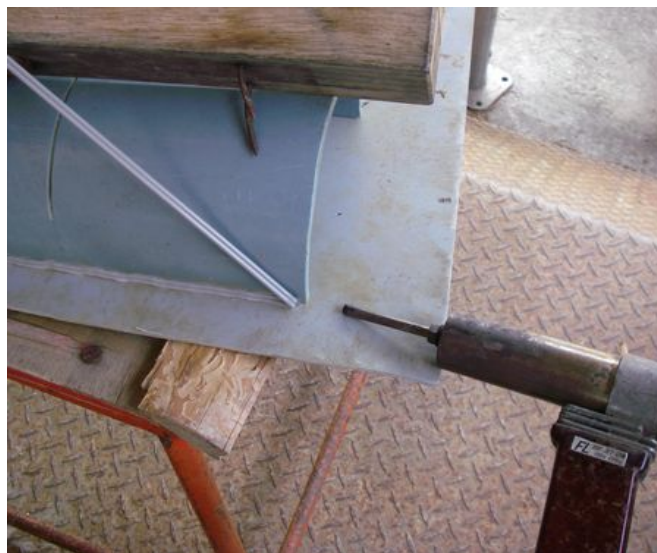
写真4 巣穴のエンビ溶接
